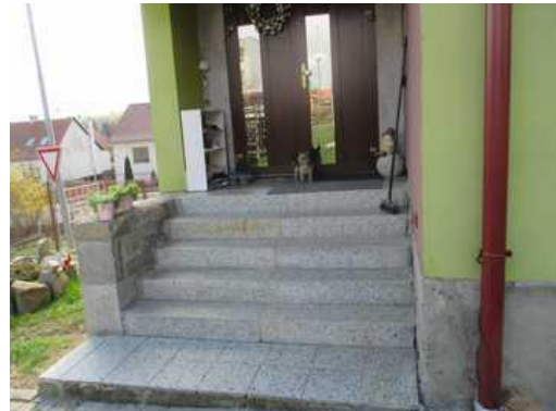
vstup do domu, závětrí
